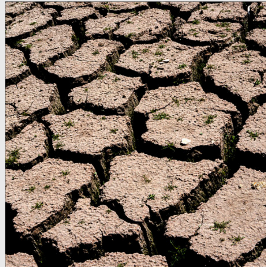
Grietas de desecación en Presa "El Jaramillo". Mineral del Chico, Pachuca, Hidalgo, México. Fotografía de Cassandra Cerón .
