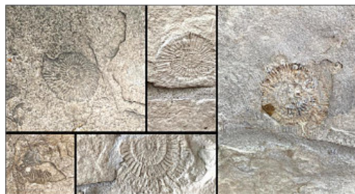
Fig. 9. Amonites en calizas de muro perimetral de edificio residencial en el barrio de Belgrano (tamaño máximo 5-10 cm)
